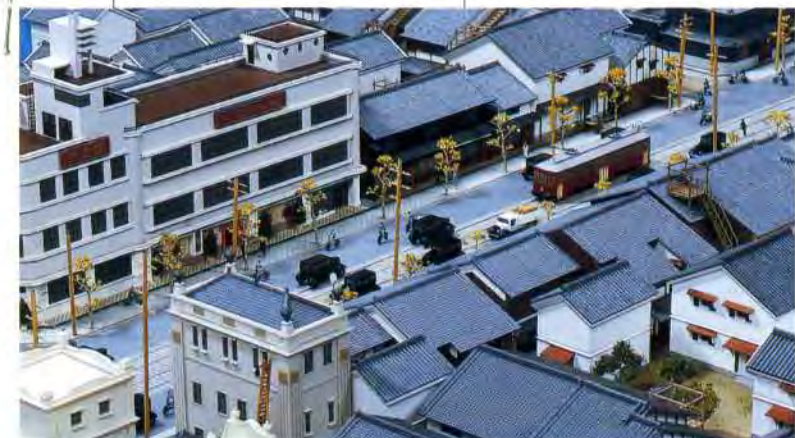
洋風建築が現れモダンな町並みになった堺筋
