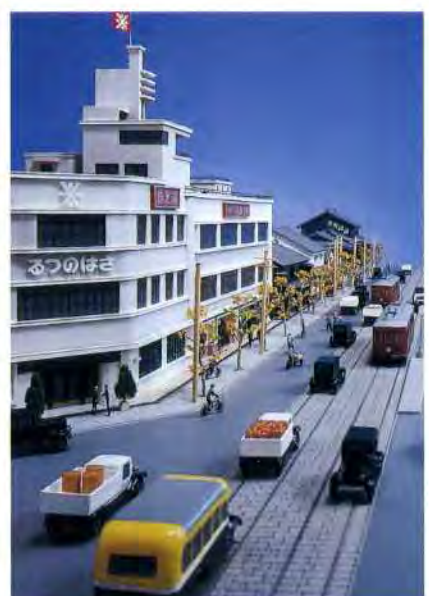
市電が走る道路拡幅後の堺筋
