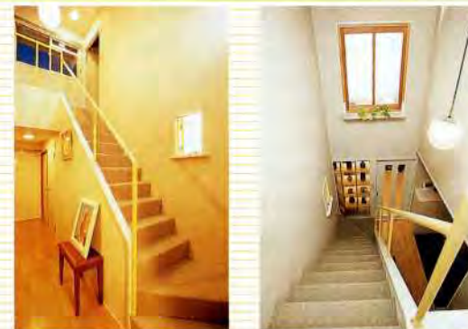
階段の手すり壁を低くして、光を通らない形状にリフォーム。以前の手すり部分の材料を生かしながら、シンプルな手すりを取り付けLDKや廊下へ光が通る設計に。キッチンと階段室との間に窓を設置。
