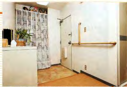
部屋の出入口の段差をなくし、随所に手すりも設置。玄関はこのようにタテヨコに手すりを設けた。
