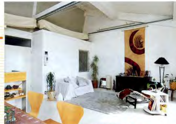
リフォーム前はフラットな天井だったものを取り払って、最高天井高4mという開放的な空間に。バスルームの閉塞感を解消するために、リビングとの間には窓を付けた。天井には可動式カーテンがあり、冬場は閉めて暖房費の節約にも。
