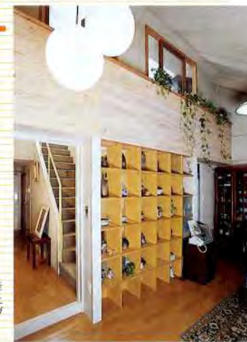
階段室とLDKの間の壁を撤去して飾り棚を設置。上階の子ども部屋とリビングの間にも窓を付けた。
