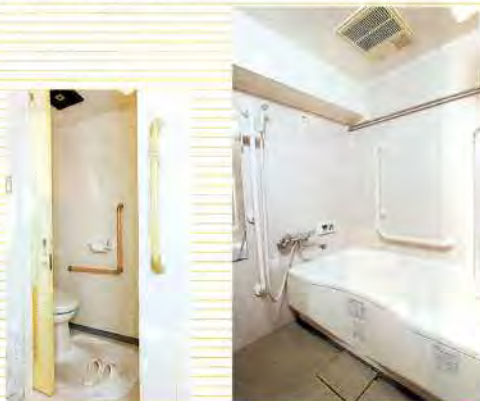
トイレのドアは出入りしやすい引き戸に。梁下の使っていないスペースを利用して広くなった浴室。浴槽の高さも低いものに取り替えて使いやすく。
