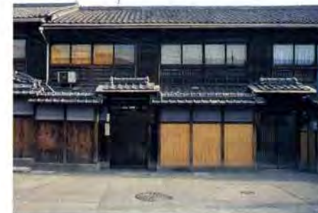
阿倍野区文の里の前廊下型の長屋。廊下のところに藤の3点セットを置いて、外を行き交いする人を眺めた。2階の道路側に廊下があるタイプは、2円〜3円ほど家賃が高かったらしい。
