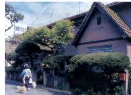
阿倍野区昭和町の洋室型の長屋。道路から1間ほど後退した母屋から洋室と台所を突出させて外観に変化をもたせている。
