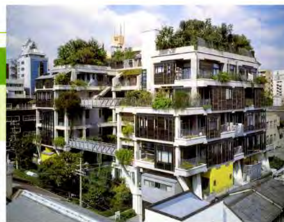
▲各住戸、共用の通路を含め、建物全体を緑化した「エコロジカルガーデン」は、NEXT21のコンセプトの一つ。
