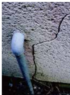
モルタルの劣化例(ひび割れ)
